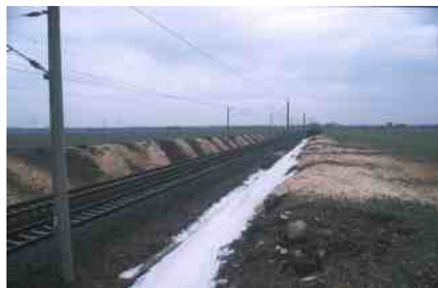
Abb. 2 und 3: Mittlerer Teil des Streckenabschnittes vor und nach der Abholzung.
